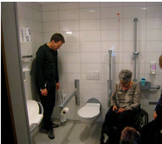
Figur 17: Test av hvor mye plass det er for pleierne, hvis det er behov for å stå mellom servanten og toalettet.
